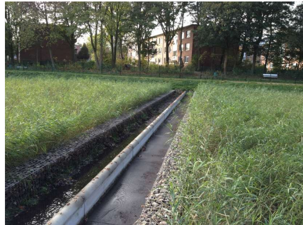
Abbildung 1.5: Retentionsbodenfilteranlage Plettenberg (Bornmühlenbach), Hamburg, Bezirk Bergedorf. RISA-Pilotprojekt (Grundlagenermittlung, Behandlungskonzept, Vorplanung und Monitoring), Quelle: Waldhoff
